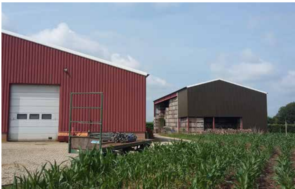
Te slopen schuren gezien vanuit het oosten.
